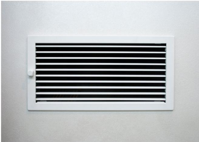
Abb. 19: Lüftungsgitter, geöffnet
